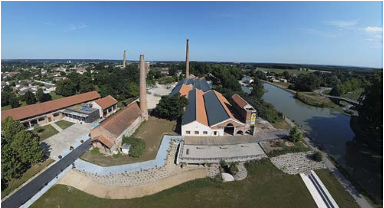
Panneaux photovoltaïques sur les toits de l'ancienne papeterie
