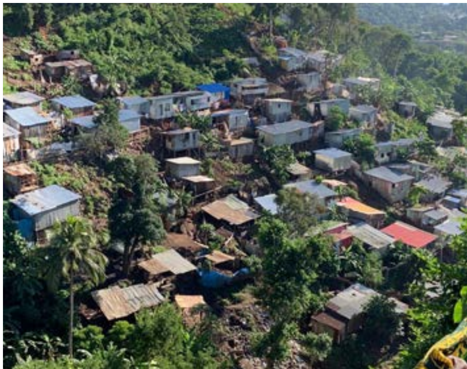
Bidonville d'immigrants à Mayotte. Les matériaux de récupération témoignent de l'autoconstruction et de la précarité des logements. Les fortes pentes et les sols dénudés laissent présager un fort risque de glissement de terrain en cas de fortes pluies. Cliché : Fahad Idaroussi Tsimanda, avril 2019.
